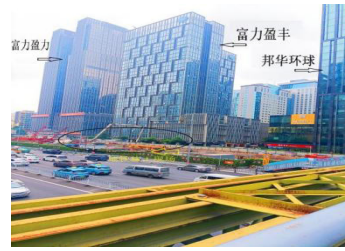
图 2 地铁施工现场
