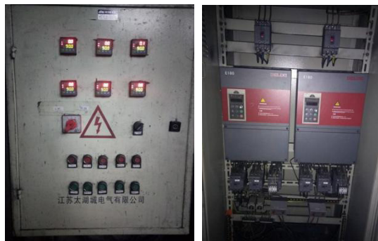
图 3 改造后博后筛变频器安装现场图
