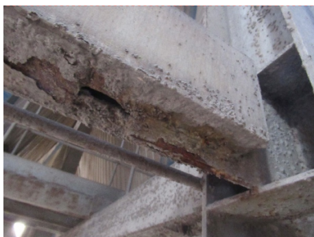
图 2 钢结构锈蚀
