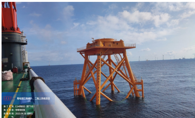
图2 海上导管架安装现场照片
