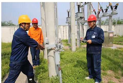
图1 电力倒闸操作现场示意图
