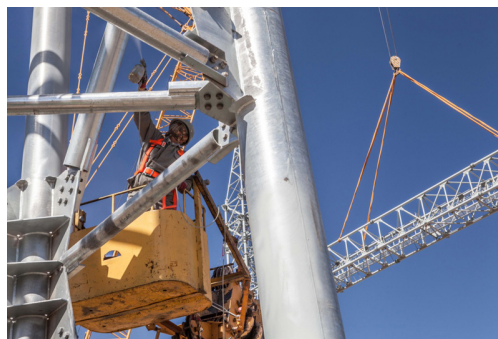
图2 输电线路施工
