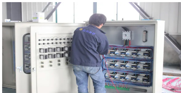
图 1 配电柜的安装
