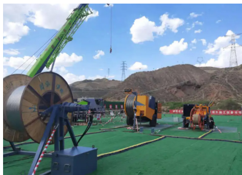
图1 张力放线施工示意图
