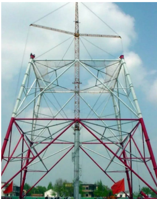
图1 杆塔组立施工实拍图
