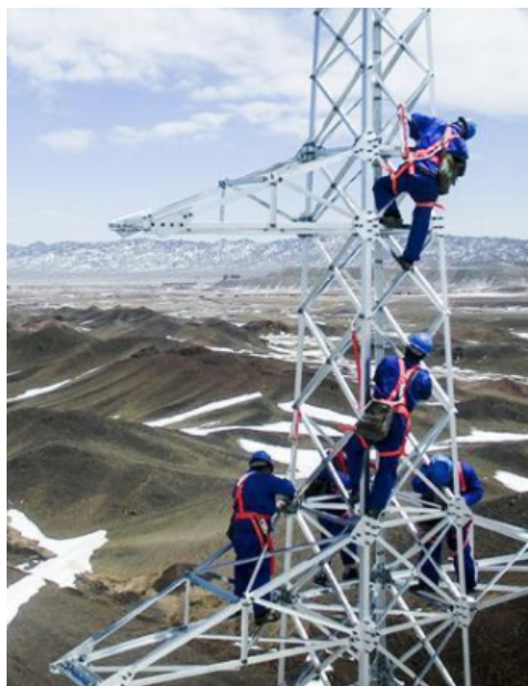
图2 杆塔组立实拍图
