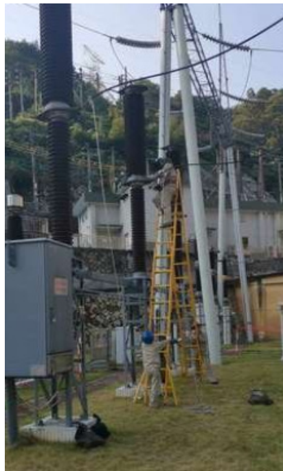
图1 变电站作业现场实拍图
