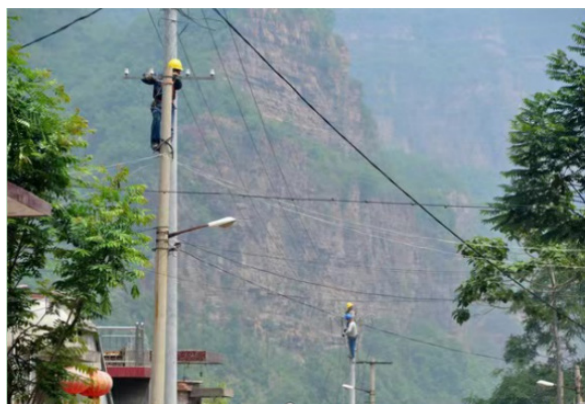
图1 电力施工工作场景
