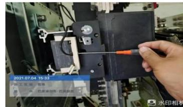
图 5 对接线端子进行紧固
