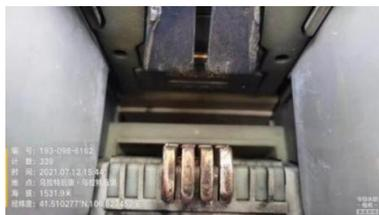
图7 主触头及灭弧触头维护前
