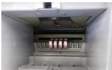
图8 主触头及灭弧触头维护后
