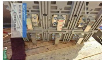
图 6 对断路器母线联结端子进行紧固
