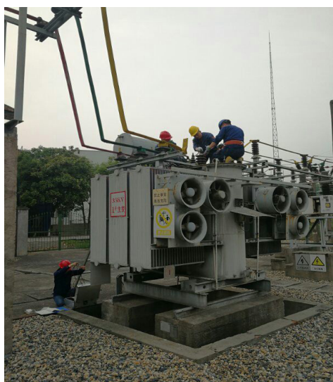
图2 接地试验
