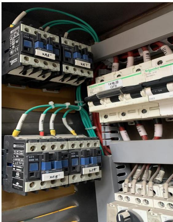
图2 现场加装施耐德 LC1D09 型接触器
