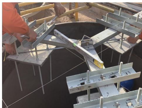
图2 预埋件布局示意图
