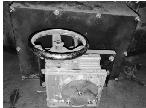
图 4 磨出口粉量分配装置现场安装效果图
