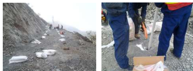
图4 现场装药示意图
