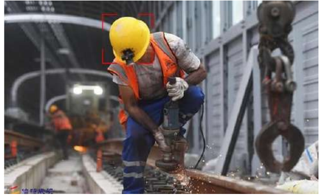
图 1 智能识别系统对施工现场安全帽佩戴进行实时监测
