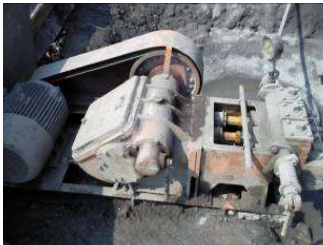
图 2 灌注桩后注浆压浆泵
