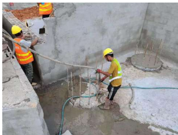
图 3 灌注桩后注浆作业
