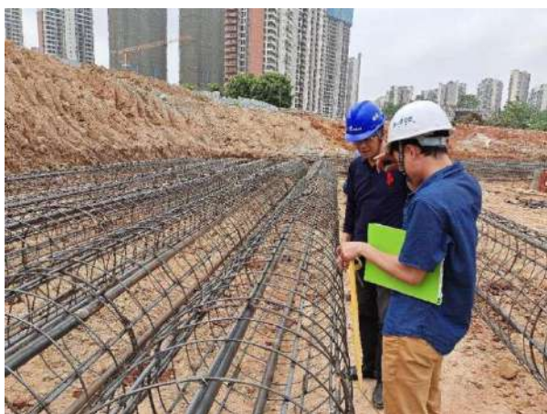
图 1 设置灌注桩注浆管
