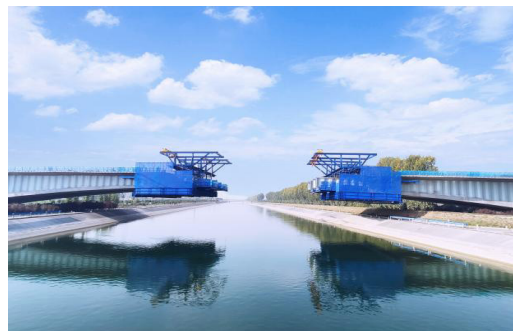
图1 140m 波纹钢腹板连续梁挂篮施工图
