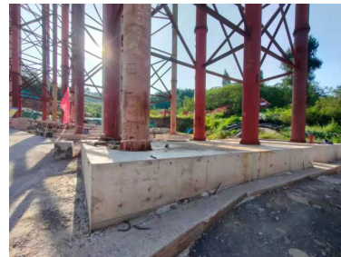
图4 钢管柱安装
