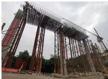
图2 梁柱式 + 盘扣组合支架
