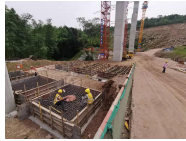
图3 支架基础施工
