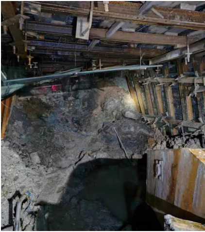
图1 连锁架棚后的支护图
