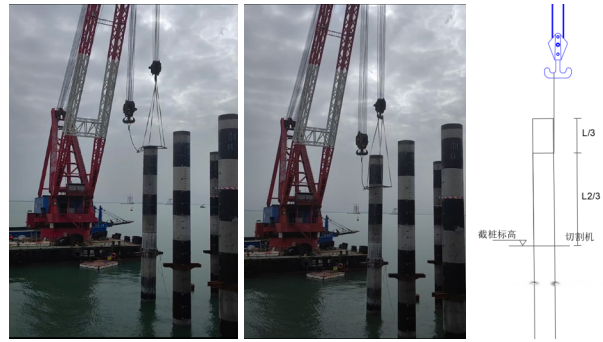
图3 捆桩吊桩示意图
