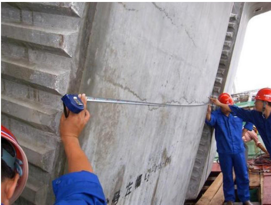
图1 桥梁裂缝测量
