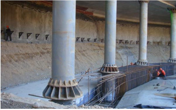
图 1 盖挖逆做法施工图
