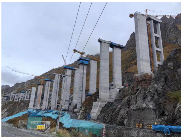
图1 高海拔地区建设公路桥梁
