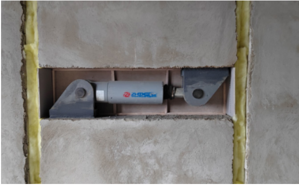
图 6 黏滞阻尼器安装完成
