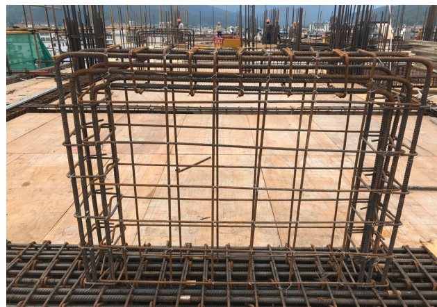
图5 阻尼器下悬臂墙钢筋绑扎
