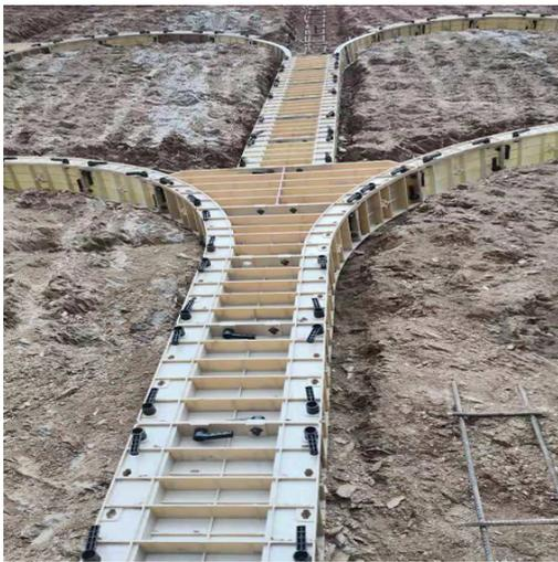
图 3 塑钢模板安装
