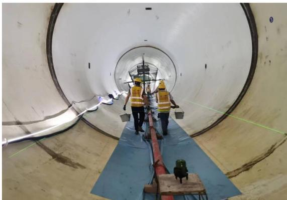
图 1 自密实混凝土入仓浇筑
