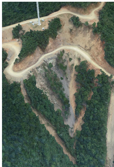
图3 上行道路与下行道路边坡交叉的长溜坡路段
