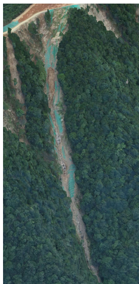
图2 由于边坡失稳导致的长溜坡
