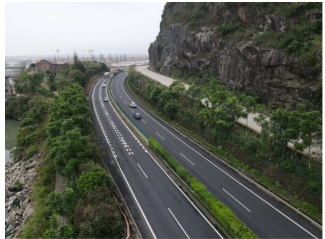
图 1 半边桥施工地貌
