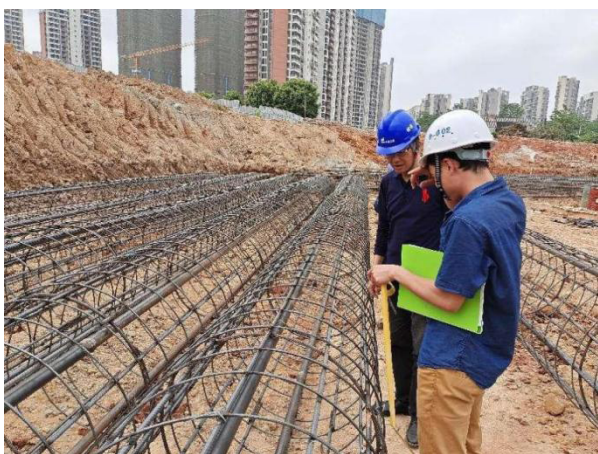
图 1 设置灌注桩注浆管
