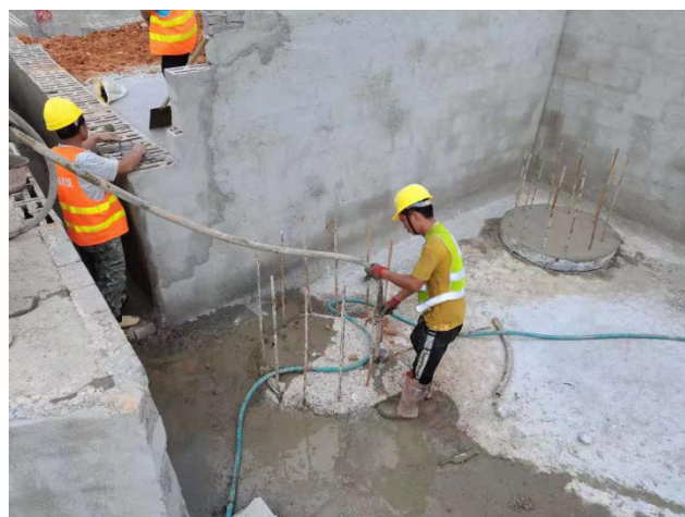
图 3 灌注桩后注浆作业
