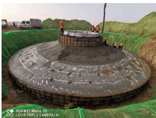
图10 风机基础养护
