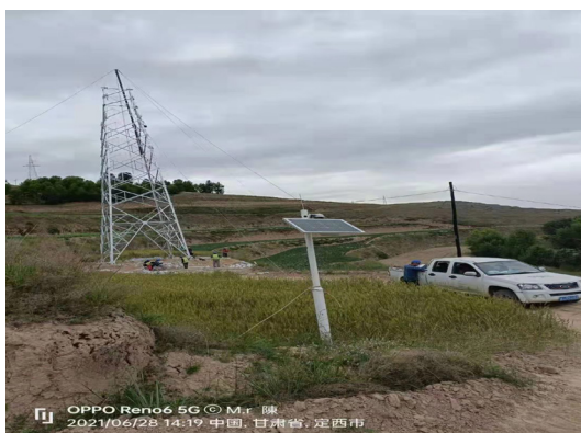
图12 集电线路组塔和架线监控
