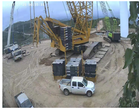
图6 远程视频监控风机吊装效果图
