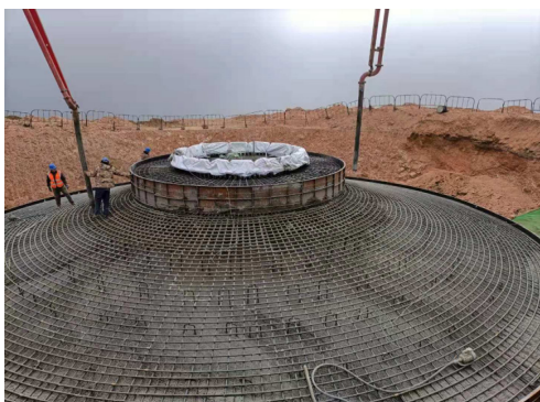
图9 风机基础浇筑
