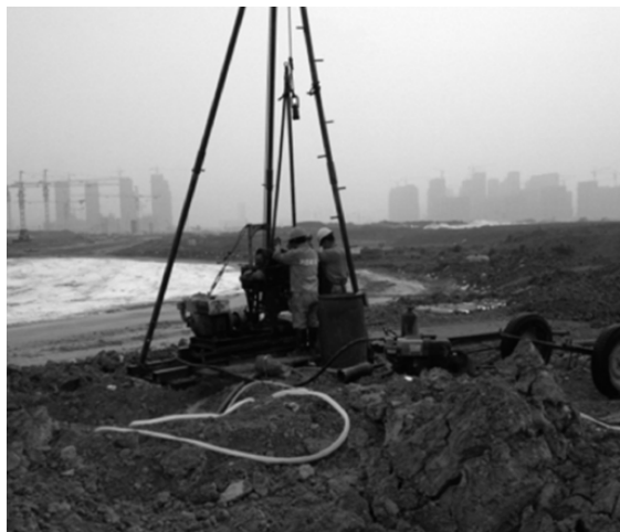
图1 岩土工程现场勘测
