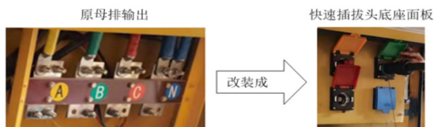
图 5 母排改装成快插底座面板示意图
