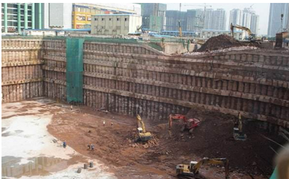
图1 深基坑支护施工
