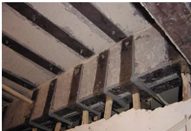
图1 粘钢加固示意图
