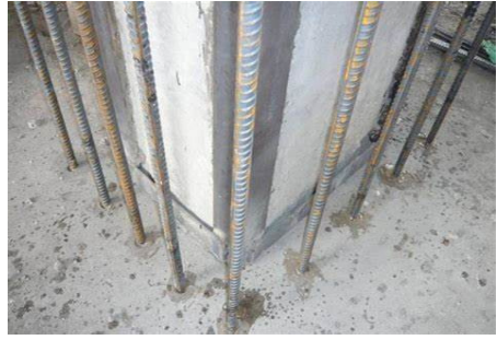
图3 植筋加固示意图
