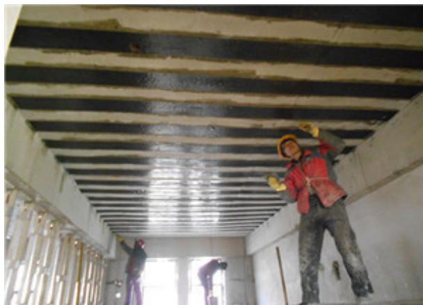
图2 碳纤维加固示意图
