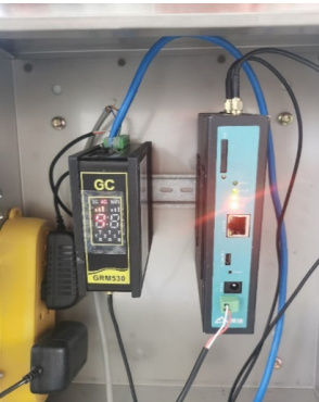
图13 LoRa 采集器安装
