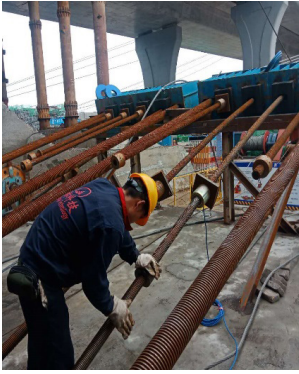
图9 锚索计安装中
