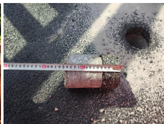
图5 路面厚度检测
