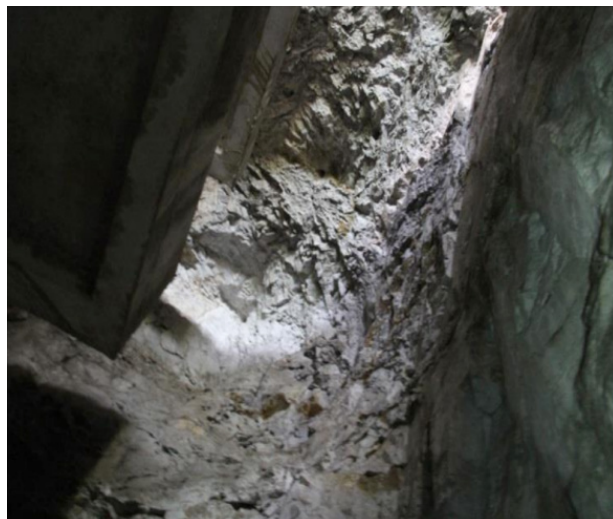
图6 洞内爆破痕迹
