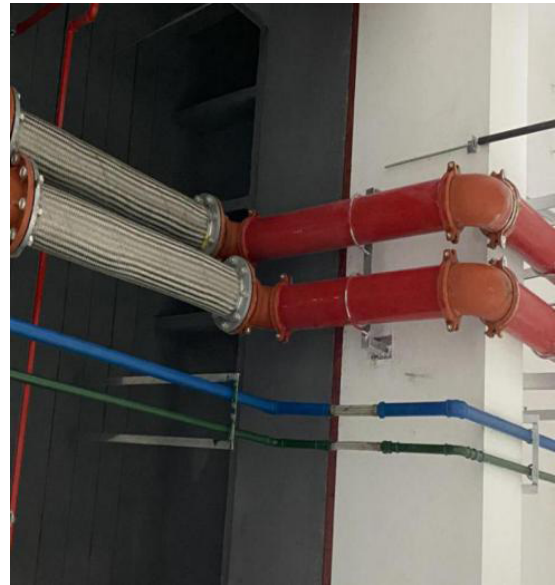
图1 不锈钢波纹管及支架设置图
