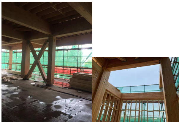
图3 木结构施工照片
