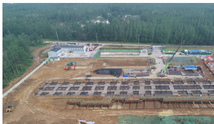
图 2 园区现场施工图
