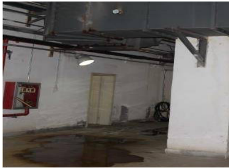
图10 烟道法兰连接处滴水
