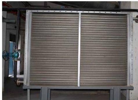
图13 鼓风机入口加装换热器后
