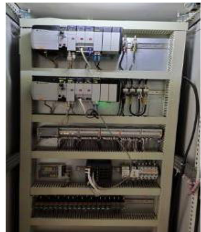
图 7 PLC 控制柜
